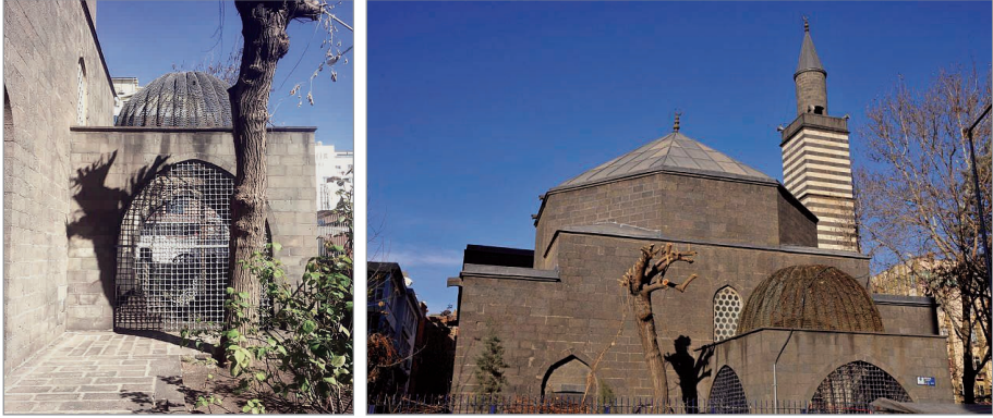
Figür 11 - Zübeyde Hanım Türbesi, Diyarbakır
